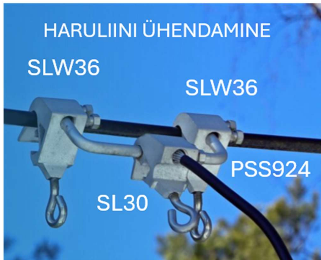
Joonis 3.1. Haruliinide ühendamine mastidel 52, 55, 65.
